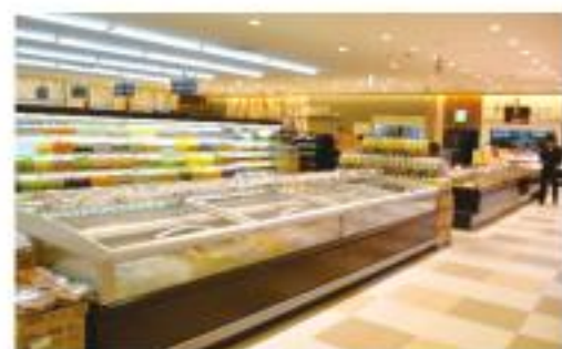
■冷凍ケースには、省エネ効果大きいガラスライド扉をオプションで設置。
